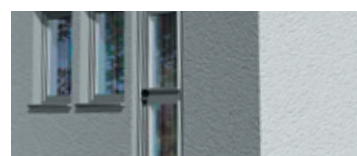
Außendämmung – Wärmedämmverbundsystem verputzt
