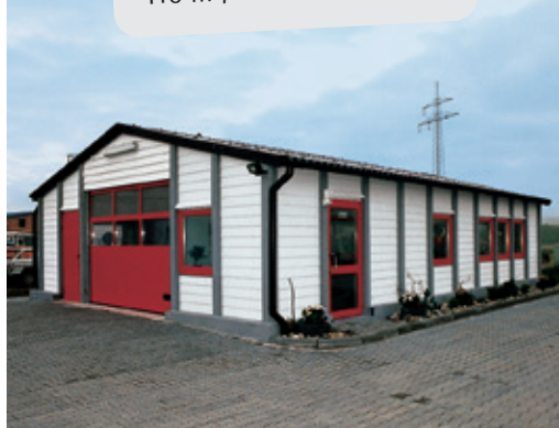
Werkstatt und Büro, 110 m 2 , Mehrzweckhaus B
