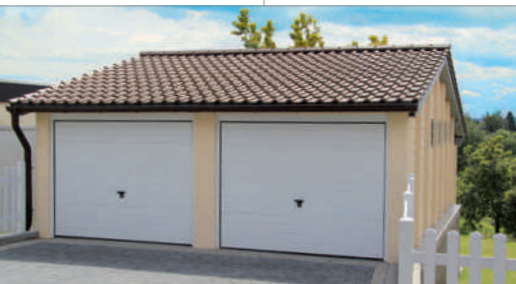
Garagen für Pkw und Lagerzwecke
