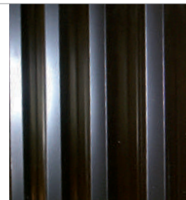
Isolierte Stahl- Trapez-Profile als Außenwand- Verkleidung
