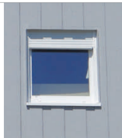
Faserzement- Panele als Boden- Deckel-Schalung
