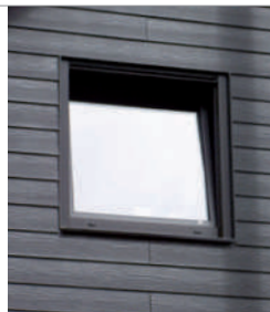
Faserzement- Panele als Stülpchalung
